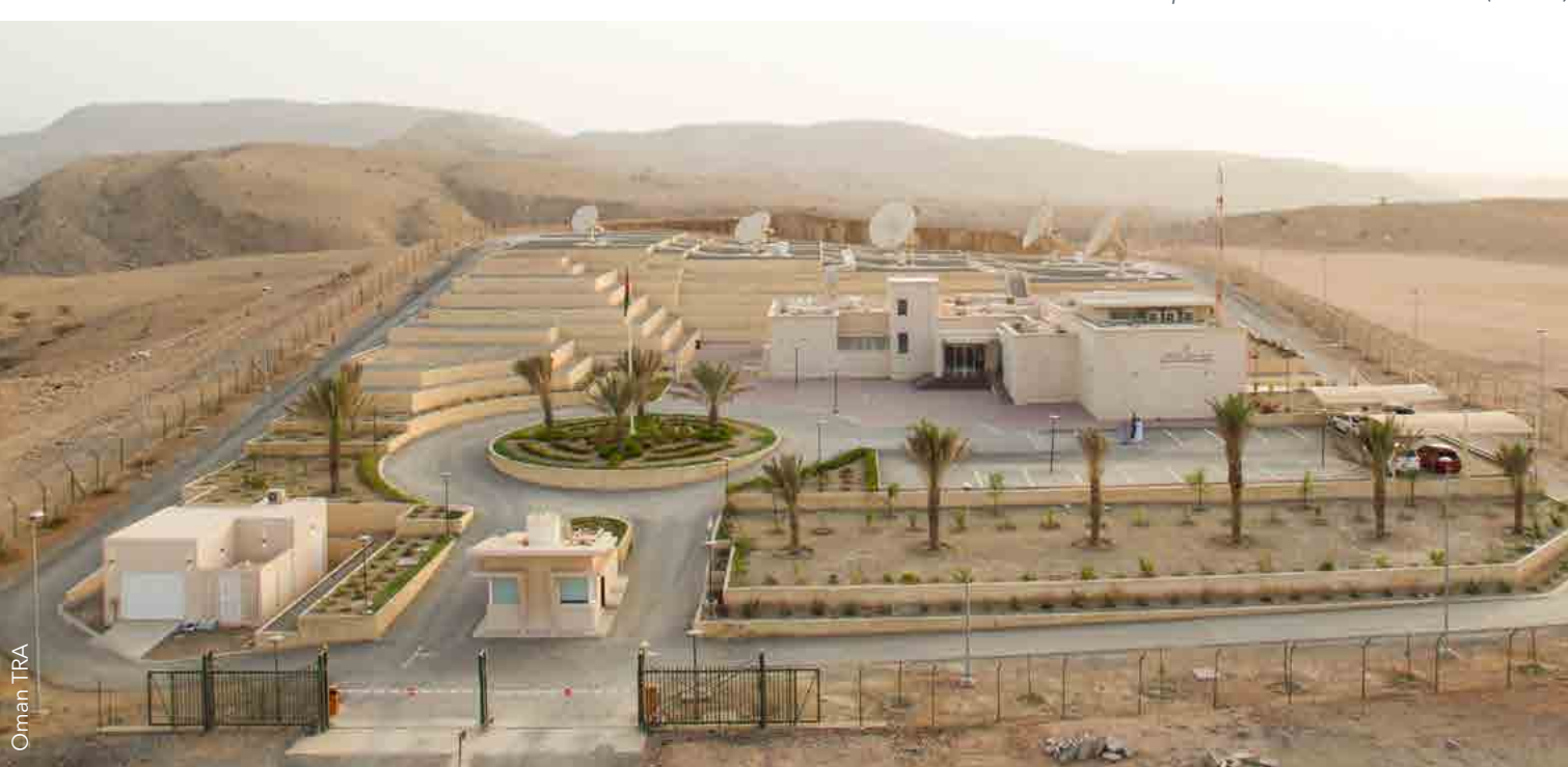
Estación de comprobación técnica de señales radioeléctricas espaciales situada en Mascate (Omán)
